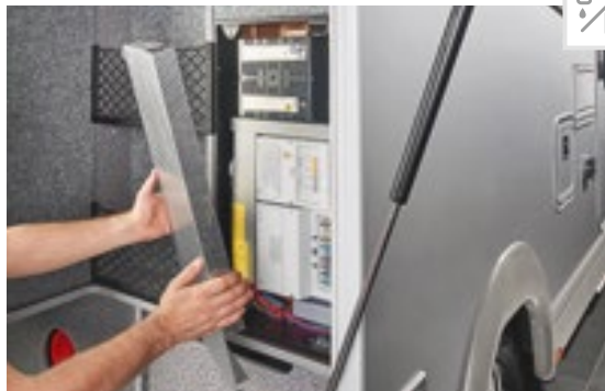
El-sentralen er lett tilgjengelig i hekkgarasjen
