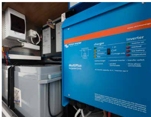
+ Victron Energy MultiPlus kombinasjon av ladeenhet og vekselretter (ekstrastyr) (4)
